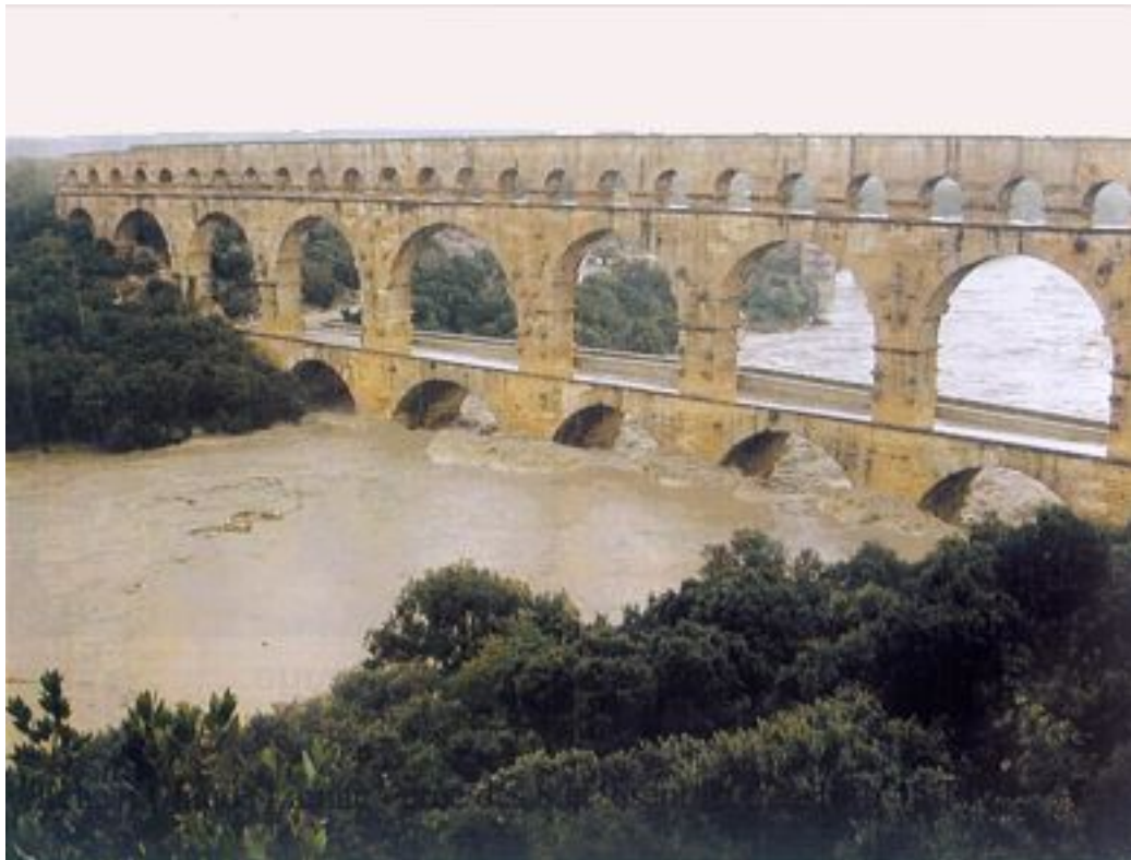
Pont du Gard (30) : crue du Gard en septembre 2002
