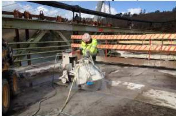
Levage et dépose dalle béton – Travée Centrale (Figure 227)
