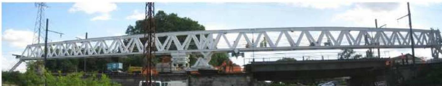
Figure 183 : vue longitudinale du lanceur (de gauche à droite : la palée arrière amovible proche de la palée centrale, le pont roulant, le tablier en cours de levage et la palée avant escamotable)
