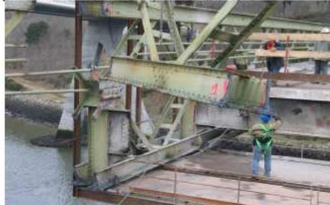
Levage Dalle Béton – Travée Centrale (Figure 230)
