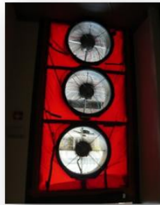
2 portes soufflantes Test d'infiltrométrie : contrôle et caractérise la perméabilité à l'air de l'enveloppe des bâtiments
