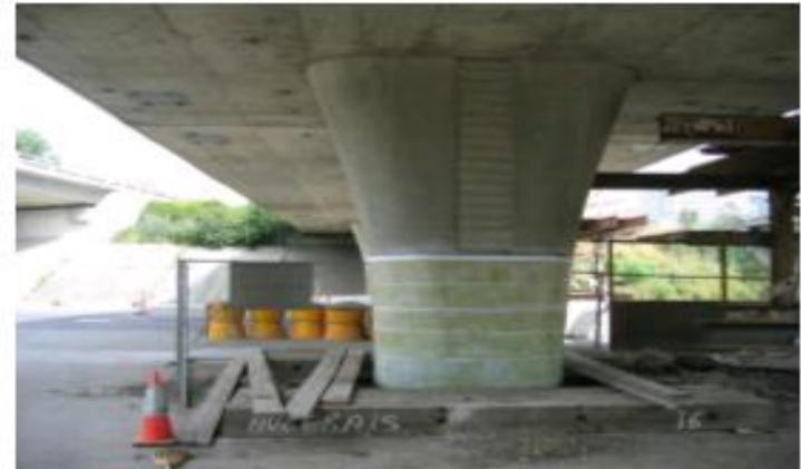
➤ Système Tyfo® en fibres de verre a enveloppé la base pour renforcement à l'effort tranchant + protection contre la corrosion
