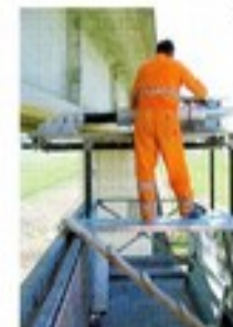
Installation d'amortisseurs
