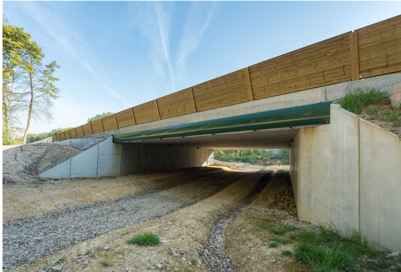
Travaux de finition, engazonnement et plantations.
