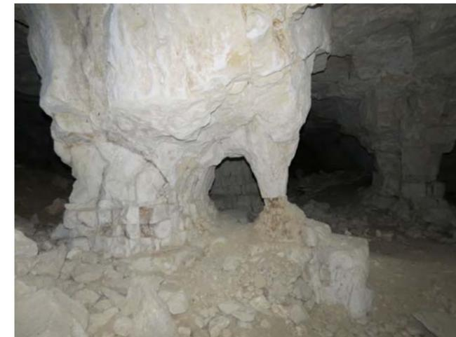
Photo 4 : Pilier dégradé d'une carrière à Charcé-Saint-Ellier-sur-Aubance
