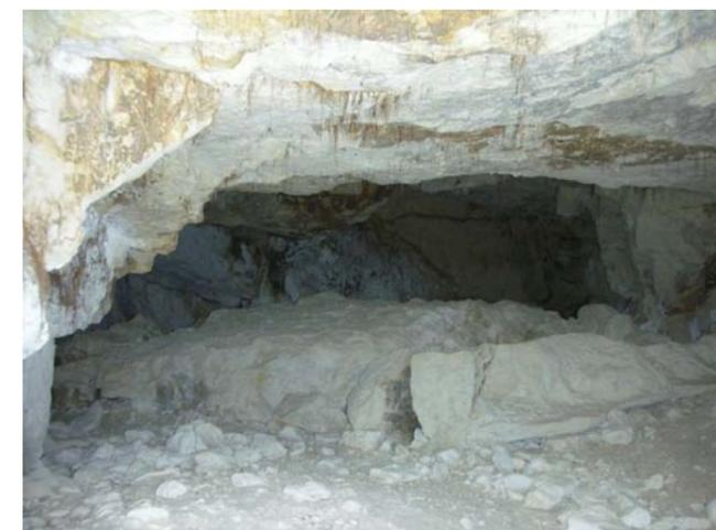
Photo 5 : Rupture d'un banc du toit d'une carrière souterraine à Blou
