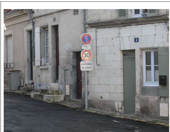
Figure 2 : panneau signalant l'existence de cavités sous la voirie communale [Cerema, 2012]
