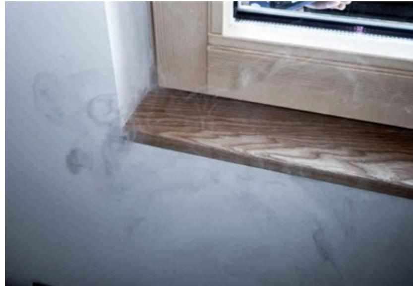
**Percement de la membrane d'étanchéité à l'air**
