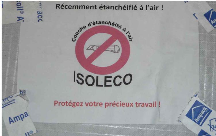
**Affiche mettant en garde contre le percement de la membrane d'étanchéité**
