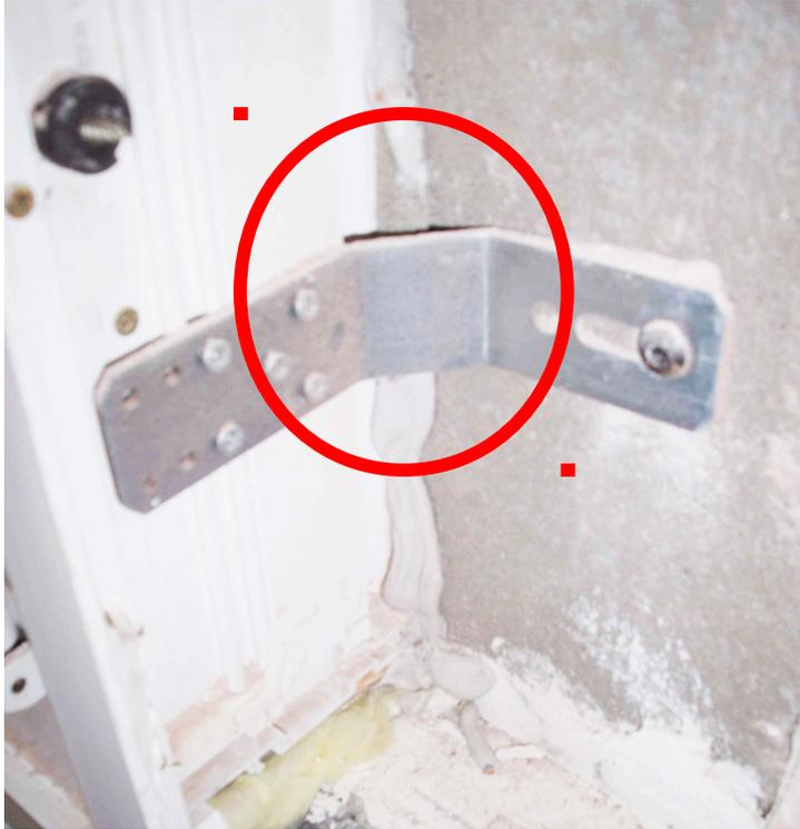
**Mauvaise réalisation du joint d'étanchéité**
