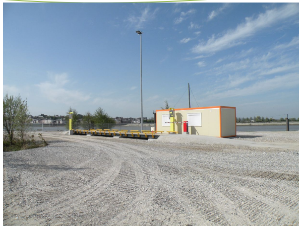
Pont bascule et cabine de pesée pour la sortie des matériaux
