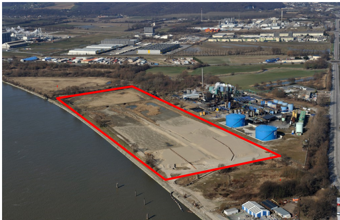
Installation de transit de Port Jérôme
