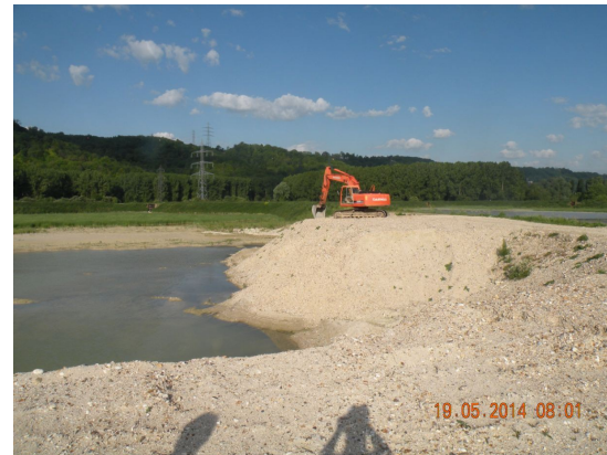
Des matériaux mélangés au sein des casiers de dépôt au fur et à mesure des apports
