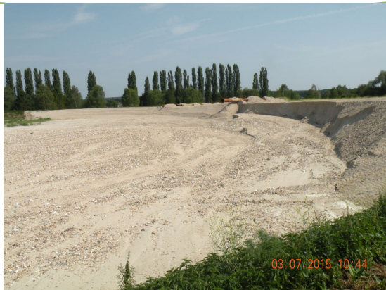
Des casiers dédiés à des types de matériaux selon les possibilités
