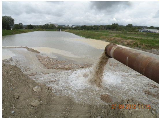
Apport des matériaux par voie hydraulique
